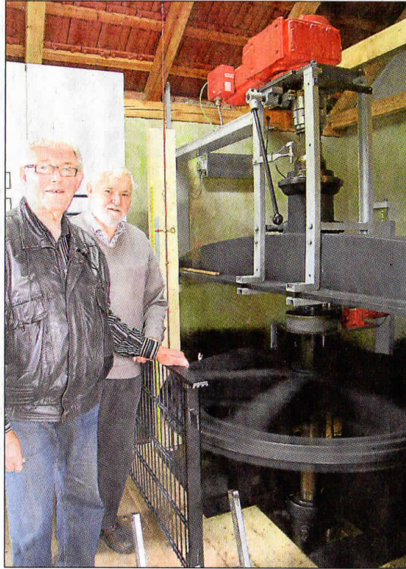
Haben Generator und Getriebe über der rotierenden Turbine installiert: Hans Huesmann (links) und Hermann Greweling. Bilder: Blumenstein
