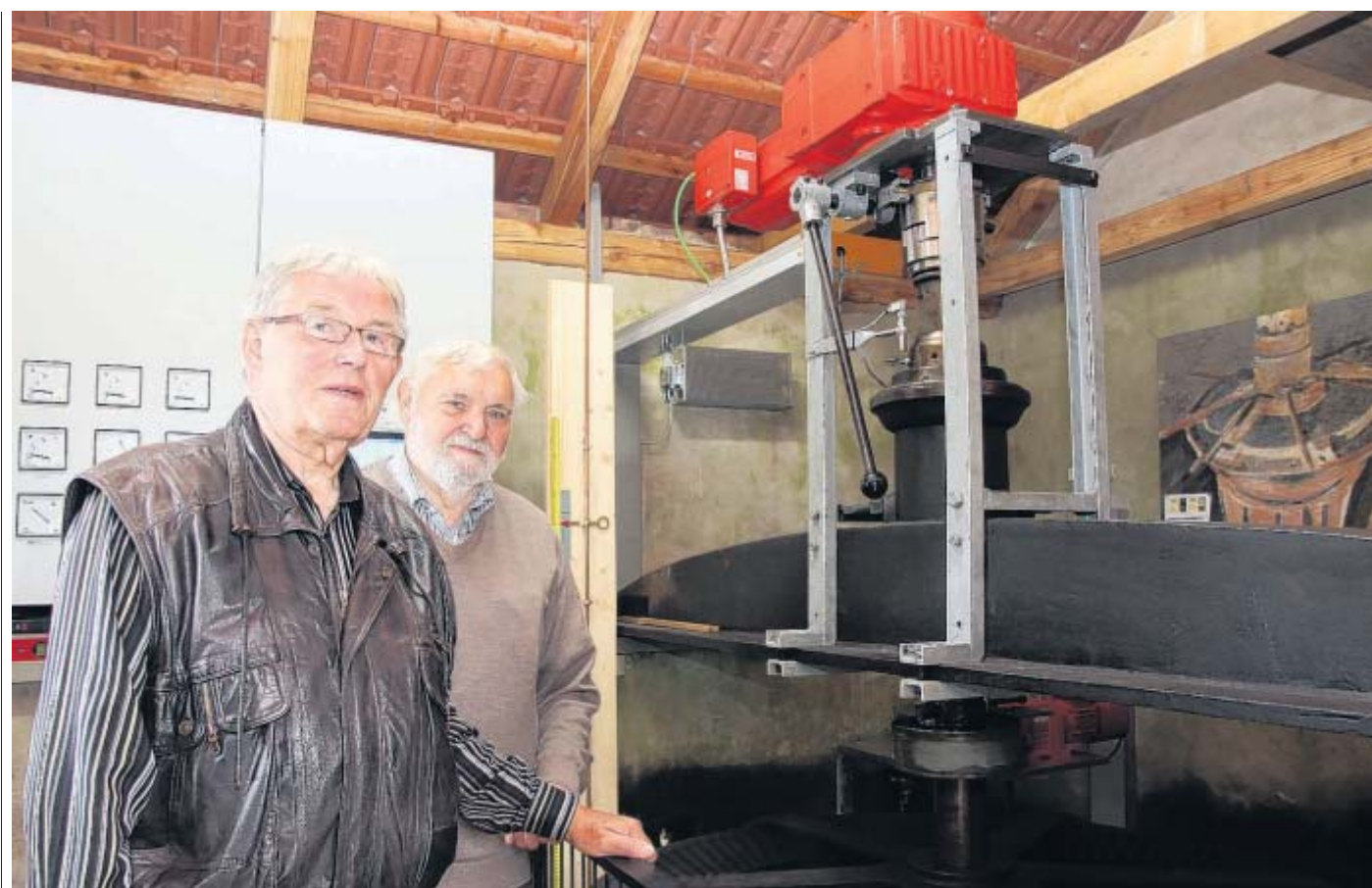
Startschuss: Hans Huesmann (l.) und Hermann Greweling haben das Energiekonzept für die Sägemühle Meier Osthoff erarbeitet. Dort wird seit gestern Strom mit Turbine und Generator (im Hintergrund) erzeugt.
