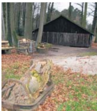
Große Pläne: Der alte Schuppen wird abgerissen. An seine Stelle kommt ein Schulungsraum.
