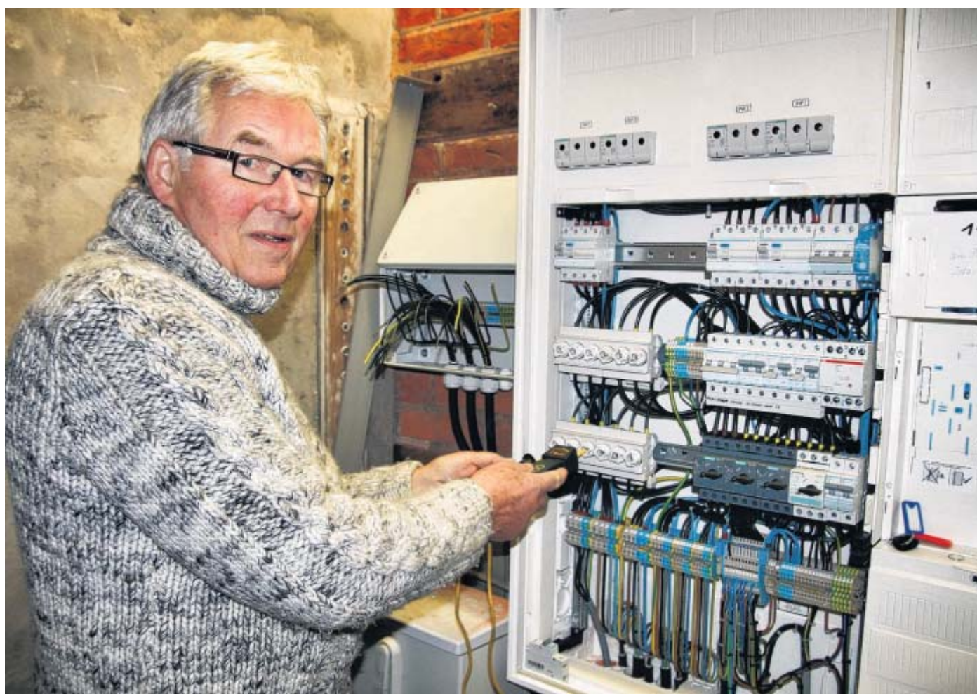
Engagierter Fachmann: Der pensionierte Elektriker Hans Huesmann opfert viele Stunden seiner Freizeit, um die Elektroinstallationen für die Stromerzeugung vorzubereiten. Der Generator soll schon im Februar in Betrieb gehen.
