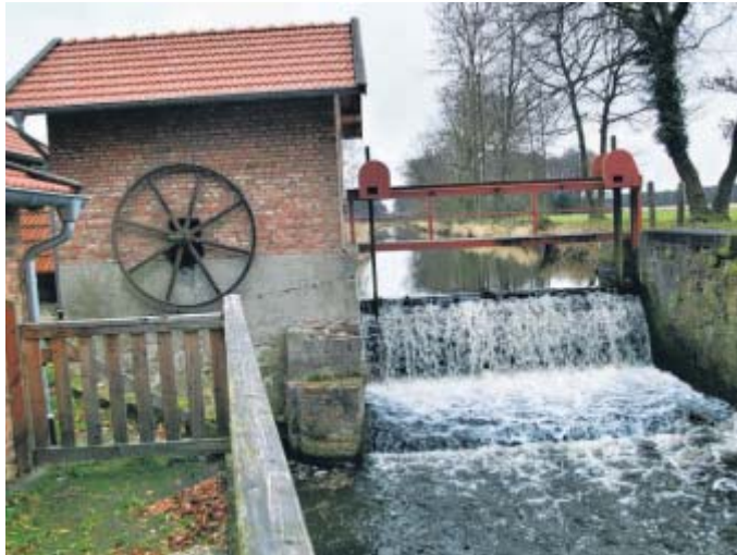
Unter Denkmalschutz: Die historische Sägemühle Meier Osthoff wird mit großem Aufwand in möglichst originalen Zustand versetzt.
